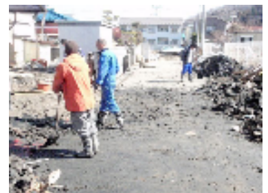
ヘドロ撤去作業をするチームメンバー。
